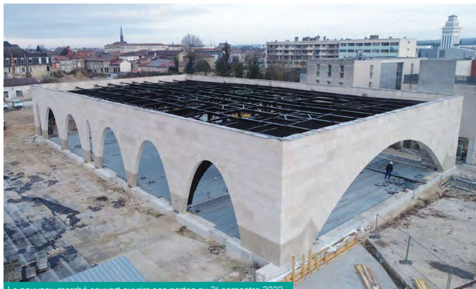
Le nouveau marché couvert ouvrira ses portes au 2 e semestre 2022.
